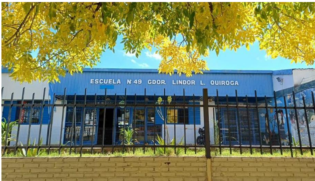
Imagen 1: Fachada principal de la Escuela N.º 49 “Gov. Lindor L. Quiroga”.
