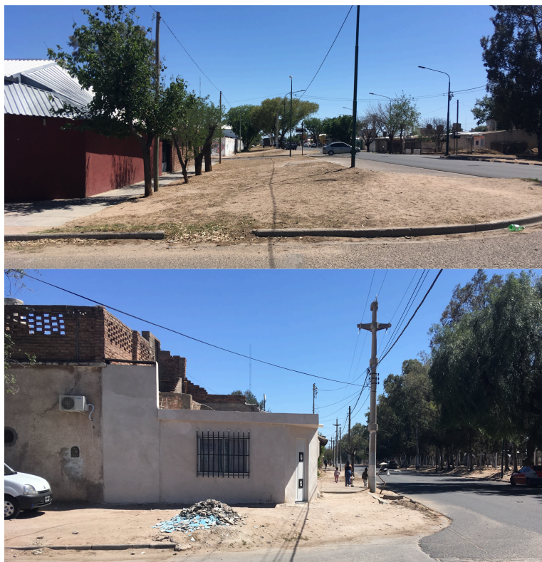
Foto 3 y 4. Arriba esquina del barrio AMEP. Abajo esquina del barrio Di Pasquo. Vista comparativa entre las veredas del AMEP, pavimentadas y distanciadas de la Av. Justo Daract, respecto de las del barrio Di Pasquo, que se encuentran a pocos metros de la calle y no poseen cordones (Palomeque Julieta, Trabajo de Campo, junio de 2022)
