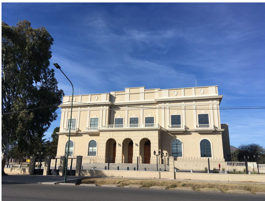
Foto 2. Edificio del Teatro Club Social desde la Avenida Justo Daract (Palomeque Julieta, Trabajo de Campo, junio de 2022)
