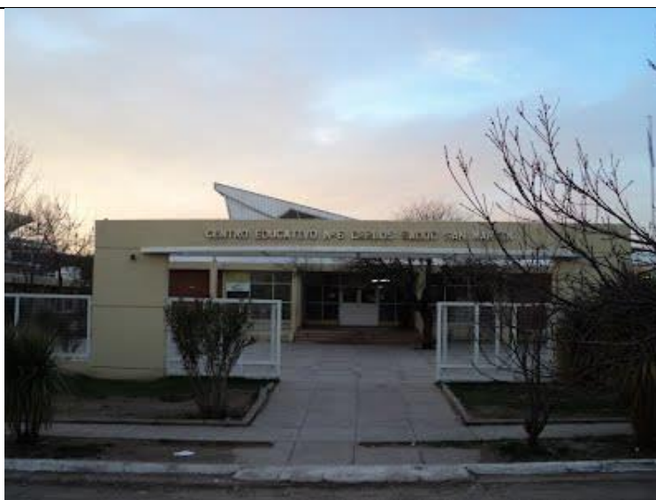
Imagen 6: Fachada del edificio del Centro Educativo N° 6 “Subsecretario Carlos Sadoc San Martin” El Volcán
